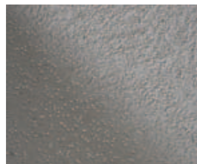
Tynk elewacyjny Stolit Effect z mikrokulkami szklanymi Sto-Glasperlen
