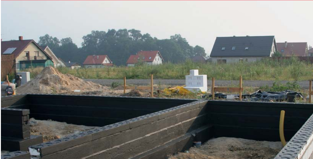
Montaż prefabrykatów keramzytobetonowych
