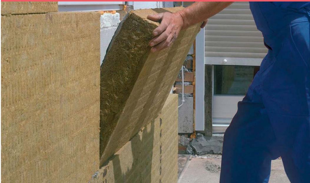
Docieplenie ściany zewnętrznej
