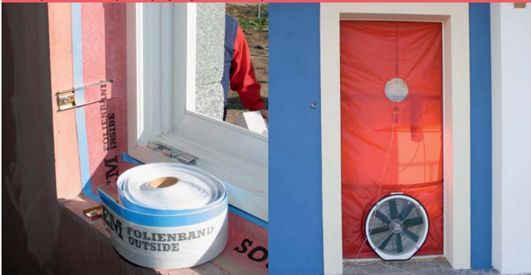
Folia paroszczelna przed przyklejeniem oraz próba ciśnieniowa
