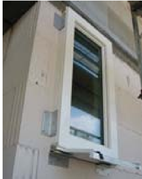
Ramy okna zamocowane są przed ścianą w warstwie późniejszego ocieplenia
