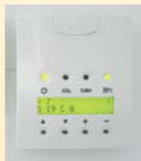
element sterujący wentylacją oferujący możliwość własnych ustawień dla mieszkańców
