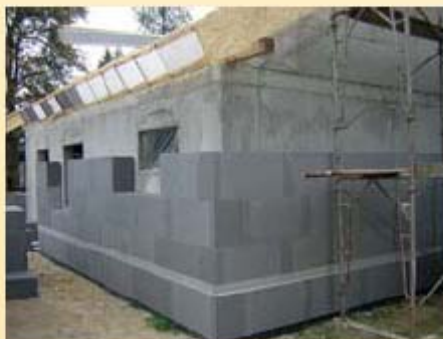
Wólka – mocowanie termoizolacji ściany
